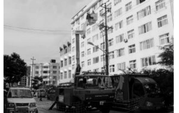
本报讯(李腾飞)“您好，我们今天是带电作业，不会影响您的正常用电，请您放心。”日前，县供电公司组织带电作业人员分别对县城东区 10kV985 线路 #073—3 杆世纪房产区 0075 变和 #073—5 杆新区移动配电室实施带电拆火和接火作业。
